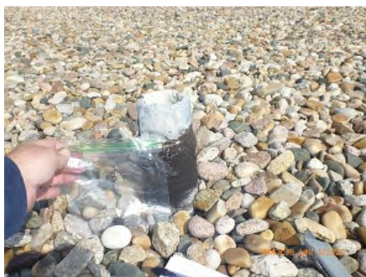
25-082-13 (S. vent pipe)
